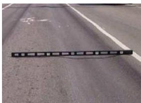
รูปที่ 3 แสดงความเสียหายของทางแบบ ร่องล้อ
