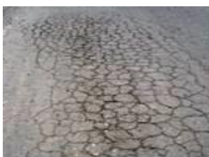
รูปที่ 4 แสดงความเสียหายของทางแบบ รอยแตกแบบหนังจระเข้
